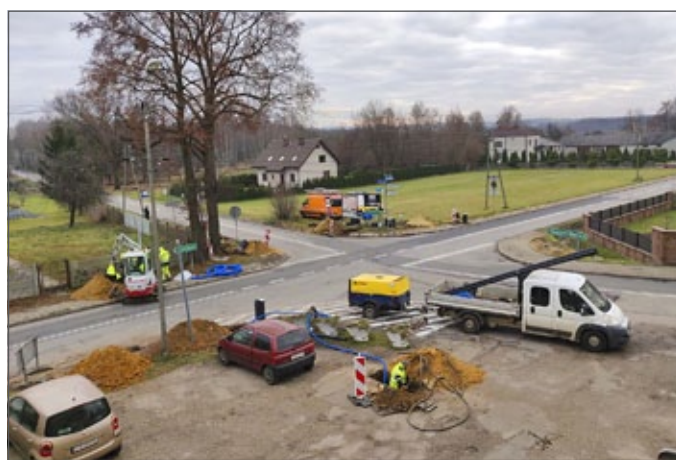
Sygnalizacja w Ożarówicach w trakcie budowy
