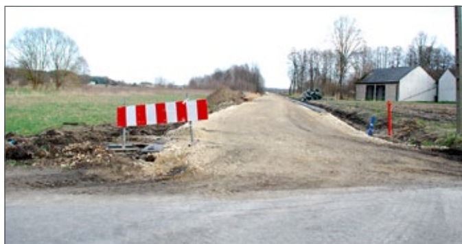
Ul. Polna w trakcie robót
