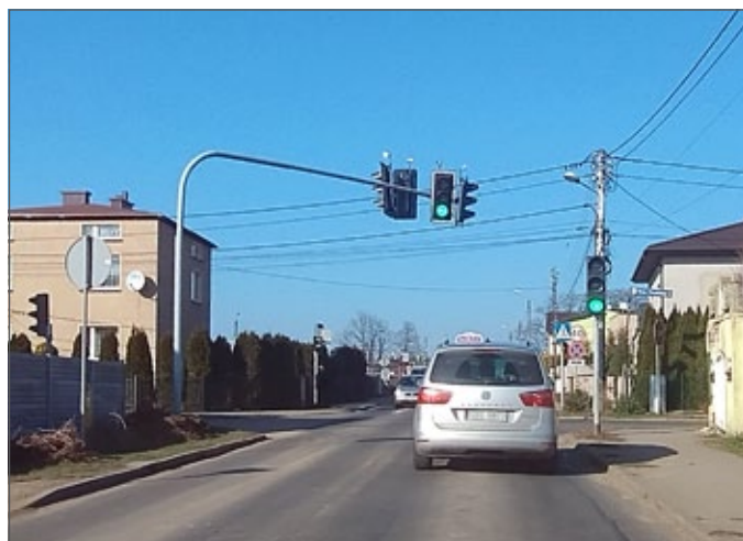
Sygnalizacja w Pyrzowicach
