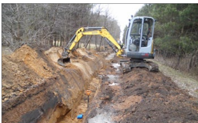
Budowa wodociągu, Ożarówice, ul. Witomin, luty 2023 r.
