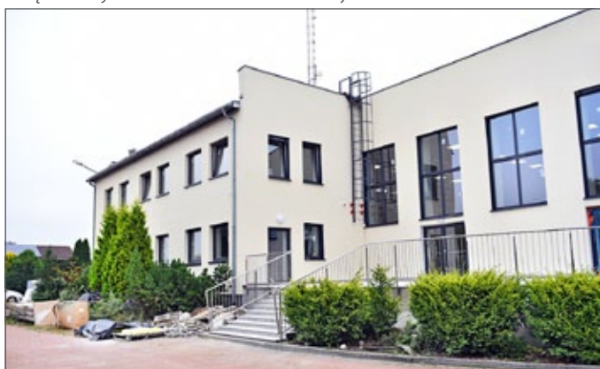
Urząd Gminy od strony zachodniej w trakcie termomodernizacji
