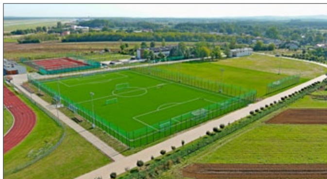
Kompleks sportowy po rewitalizacji
