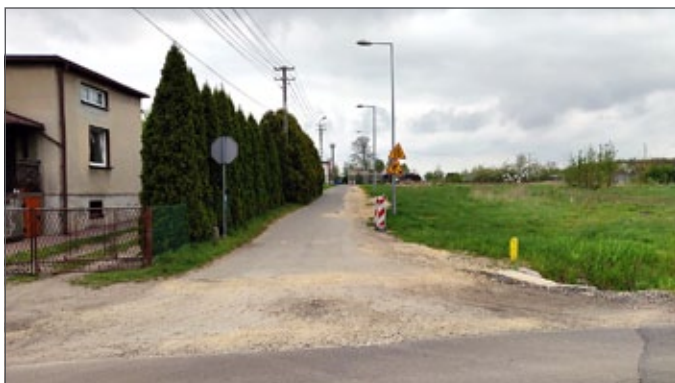
Ulica Sportowa przed rozpoczęciem robót
