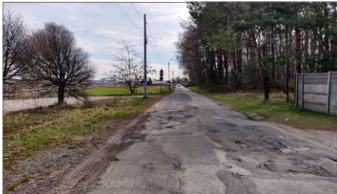
Ul. Zubrza i Kolejowa przed rozpoczęciem robót
