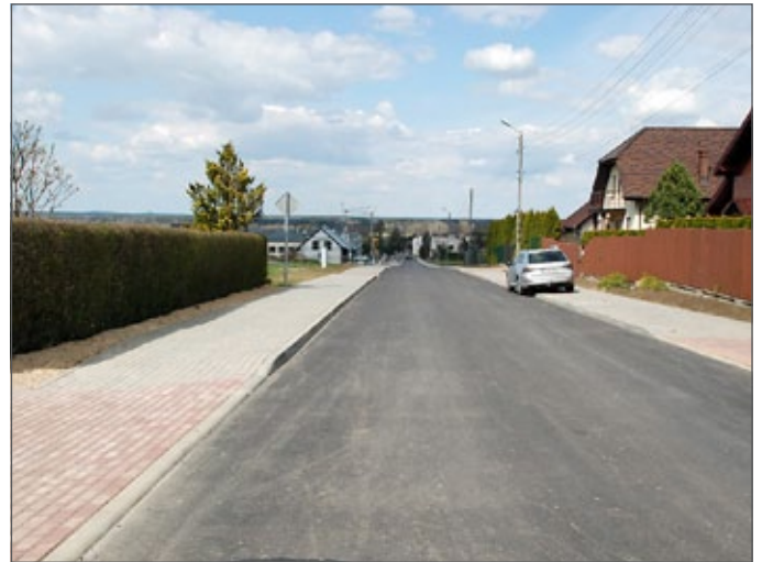
Ulica Kopernika po przebudowie
