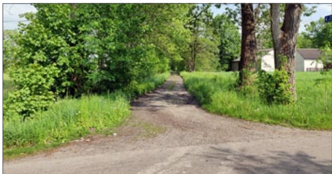
Ul. Polna przed przebudową
