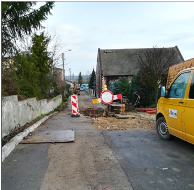
Budowa kanalizacji w Tąpkowicach
