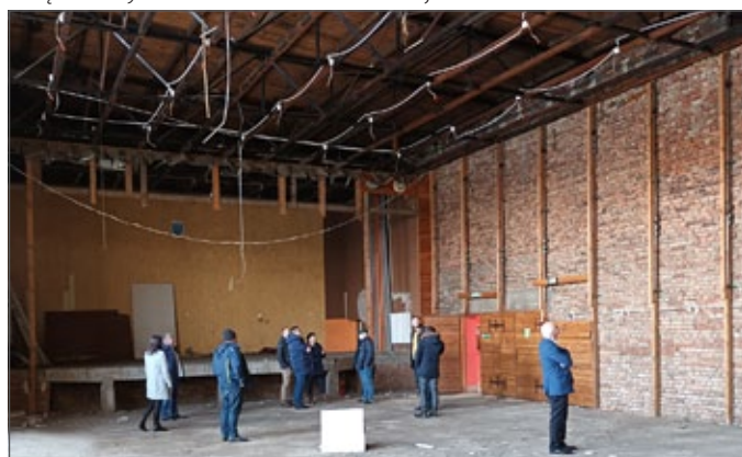
Przebudowa sali OSP
