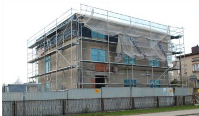
Budynek przy ul. Zwycięstwa 23 w trakcie przebudowy
