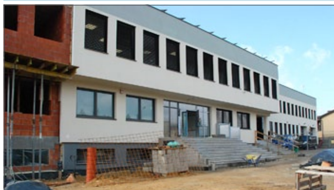
Urząd Gminy w trakcie termomodernizacji
