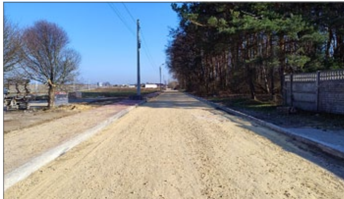
Ul. Zubrza i Kolejowa w trakcie robót
