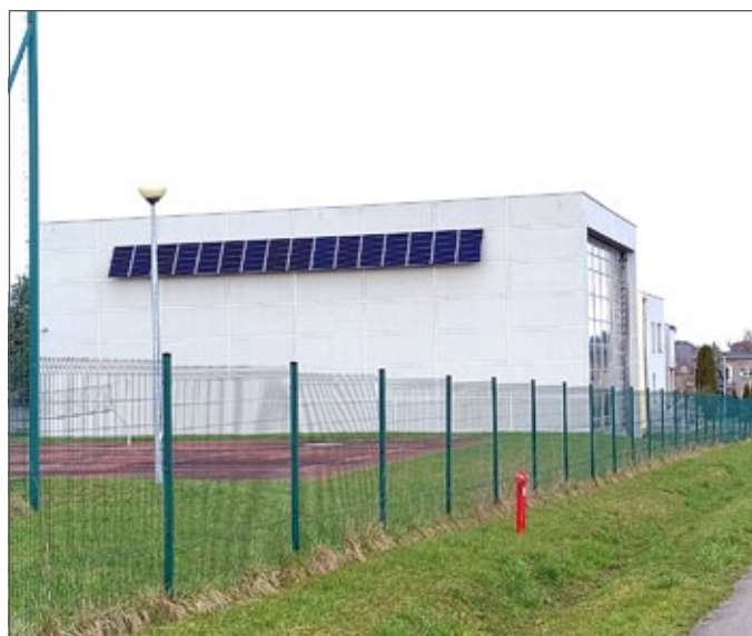
Rozbudowana instalacja fotowoltaiczna na budynku szkoły w Zendku
