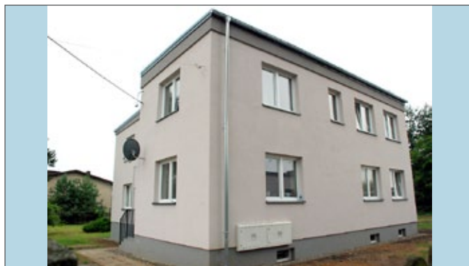
Budynek „Agronomówki” po termomodernizacji
