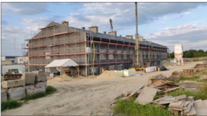
Budowa przedszkola i żłobka w Tąpkowicach
