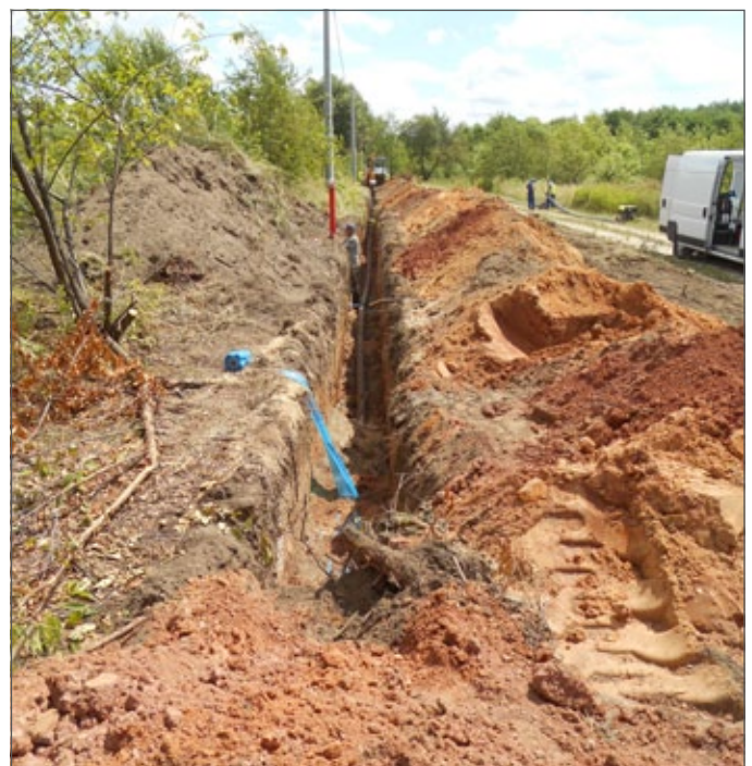
Budowa wodociągu, Ossy, ul. Leśna – boczna bez nazwy
