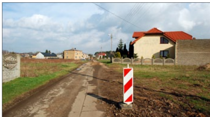
Ul. Towarowa w trakcie robót
