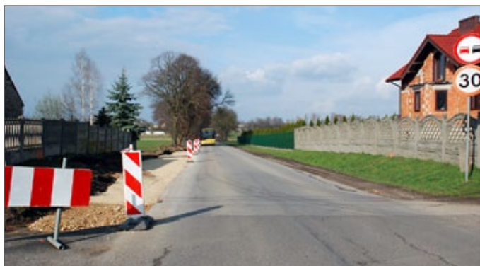
Budowa zatok autobusowych przy ul. Dworcowej
