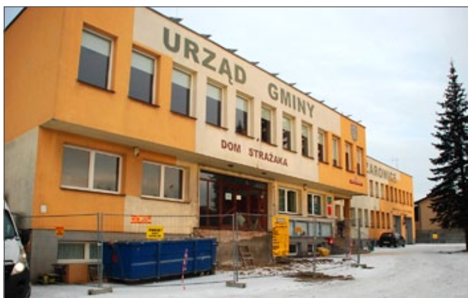
Urząd Gminy w trakcie termomodernizacji
